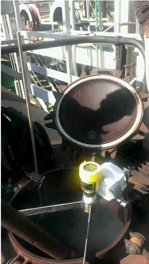
Digamos, por ejemplo, que está considerando usar un nodo Sentinel HART en combinación con un sensor de radar guiado VEGAFlex 81 para la medición continua de líquidos inflamables dentro de un tanque.
